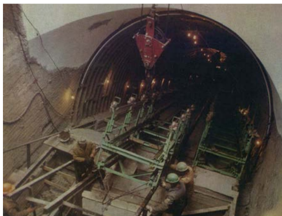
Монтаж эскалаторов на «Шаболовской» (1979)
